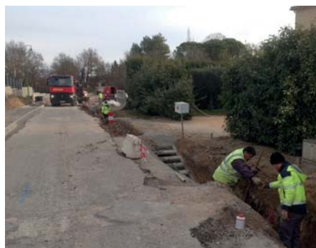
Calibrer les fossés, traiter les gaines existantes, curer les fossés...
