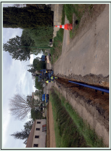
Travaux réalisés par la SRDE chemin du Serre de Lamant.
